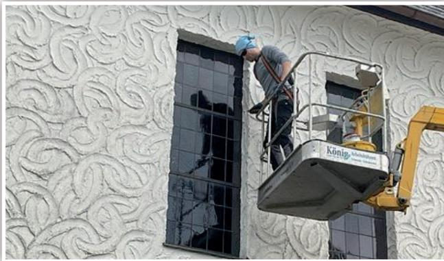
Alle Seitenfenster sowie die Fenster an der Eingangsseite wurden vor Ort innen und außen gereinigt, gebrochene Gläser herausgelöst und neue Teile eingefügt.
